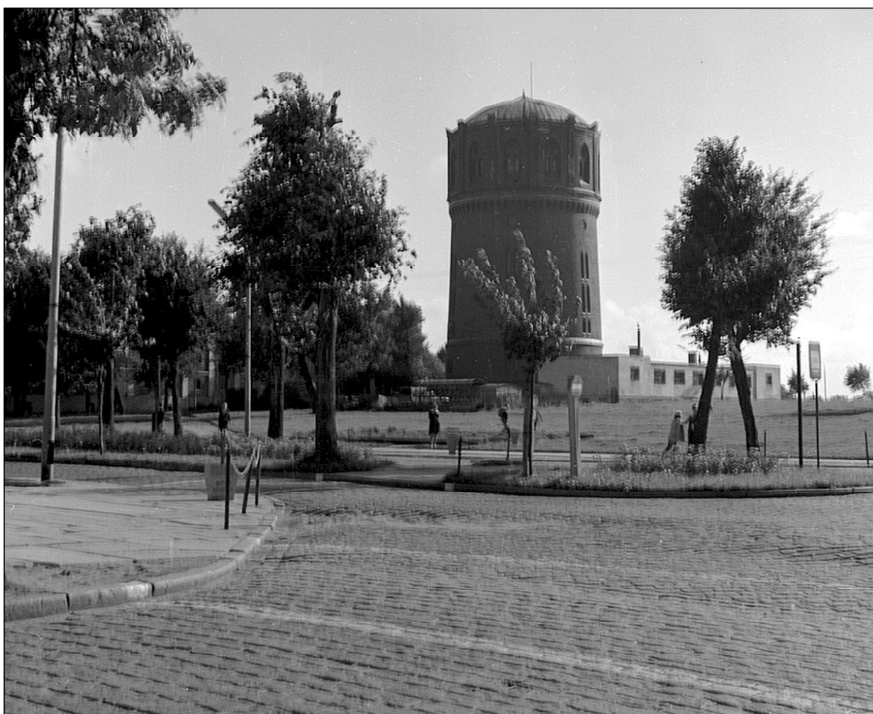
(1966) Wieża ciśnień przy ulicy Bieruta oraz pusty plac pomiędzy ulicami Gięldową i Walki Młodych.
